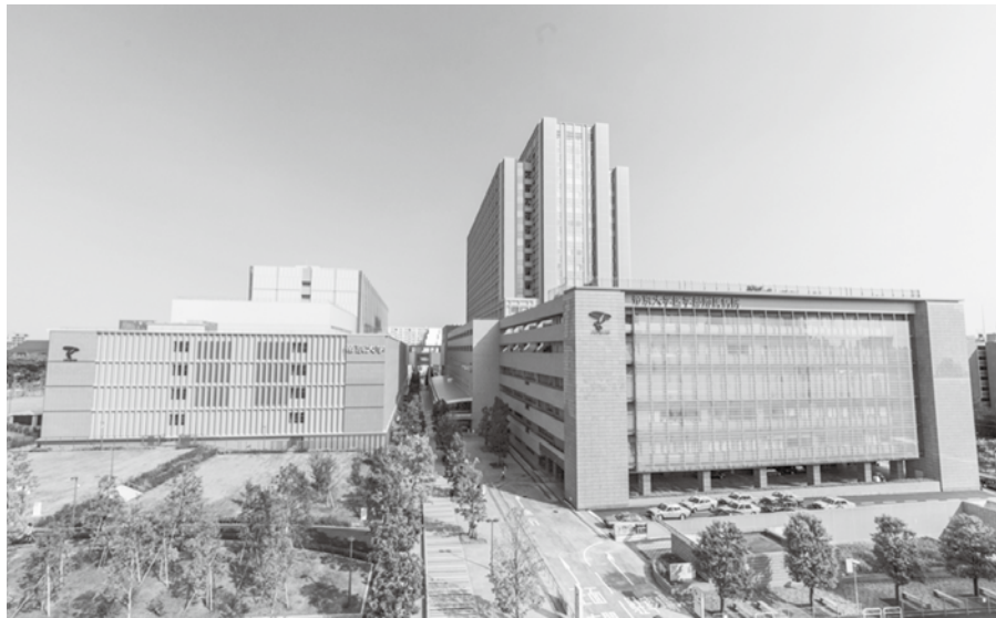
向かって右手前が外来棟(その上が屋上庭園)、その奥が18階建ての病棟、左が大学等で、中央の歩道を挟んで1階両側にお店が並んでいます。左手の芝生が前庭、右端に石神井川の桜並木がちょっと写っています。
